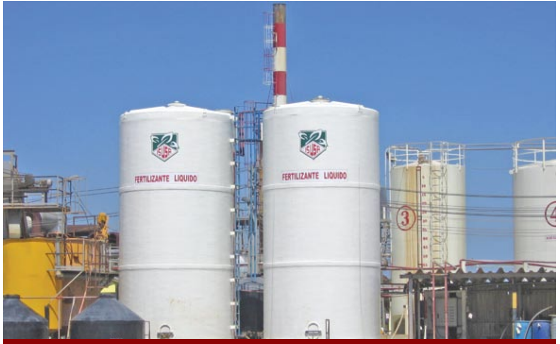
Tanques de fertilizante líquido en la Planta de ISUSA en Ruta 1 Km. 24
