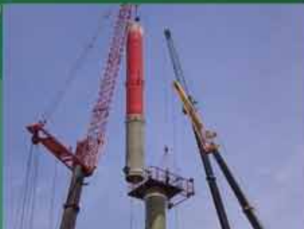
ISUSA instaló una nueva chimenea en Ruta 1
