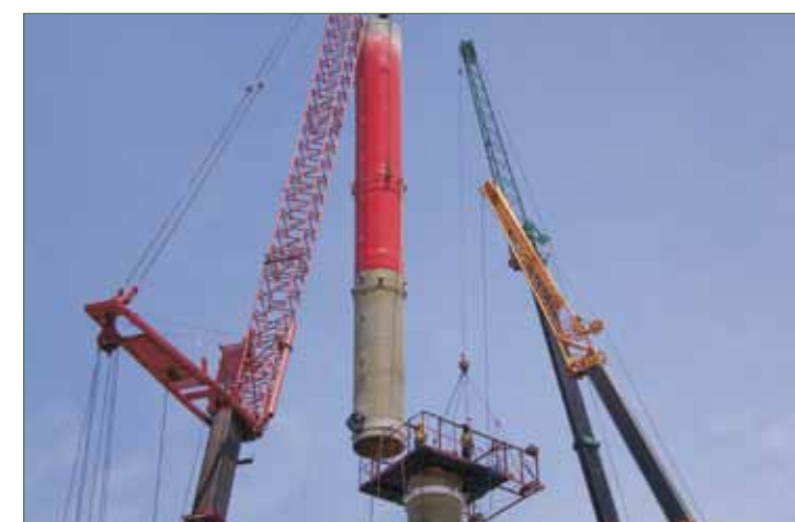
Unas 100 personas trabajaron en la construcción e izado
